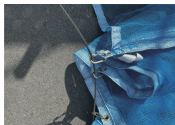
C型リングとワイヤーを連結させる
